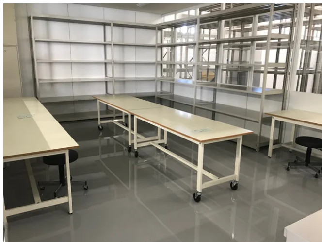
スチールラックと作業台の設置
