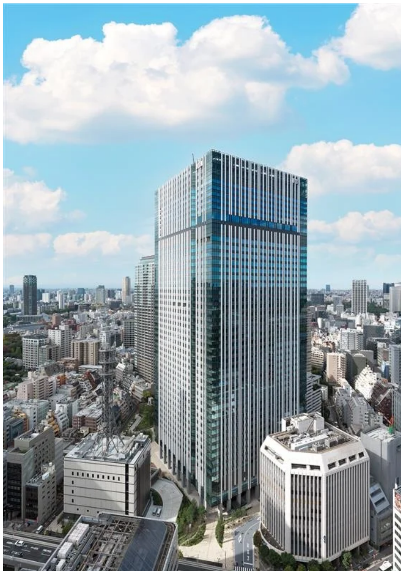
赤坂トラストタワー
