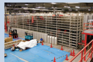
コンベヤ設置
