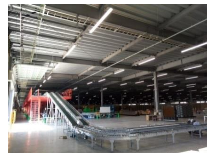
笠間DC設備拡張工事の状況
