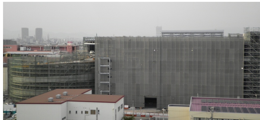
建設中新物流センター (現センター屋上より撮影)
